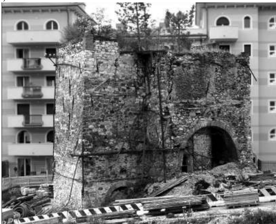
Fig.1. La fornace nel 2008 prima dell'intervento di restauro. In elevato sono visibili i due corpi di fabbrica, il piano terreno non era più visibile perché in seguito all'abbandono della fornace negli anni sessanta era diventato un cumulo di terreno di riporto e una discarica.
