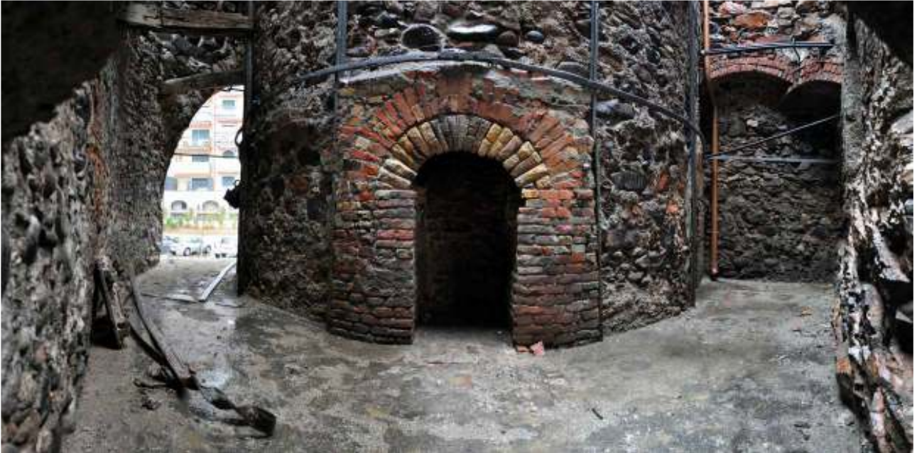
Fig. 34. L'interno della fornace al piano primo, quello dei "fornelli".
