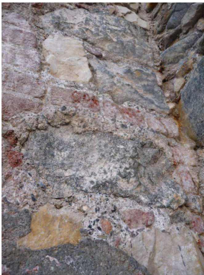
Fig. 14. Tratto di muratura del fronte nord, dopo il restauro. Come mostra l'immagine è ancora possibile leggere tutte le stratificazioni avvenute nel tempo.
