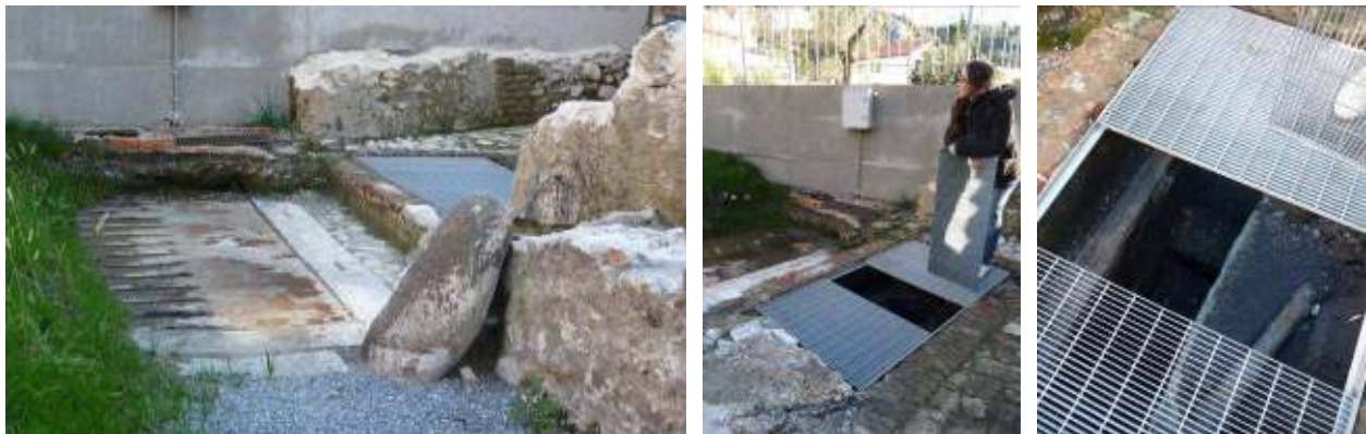
Figg. 31, 32, 33. Particolari della “pesa” e della stretta scala in pietra di accesso al vano di ispezione del bilico
