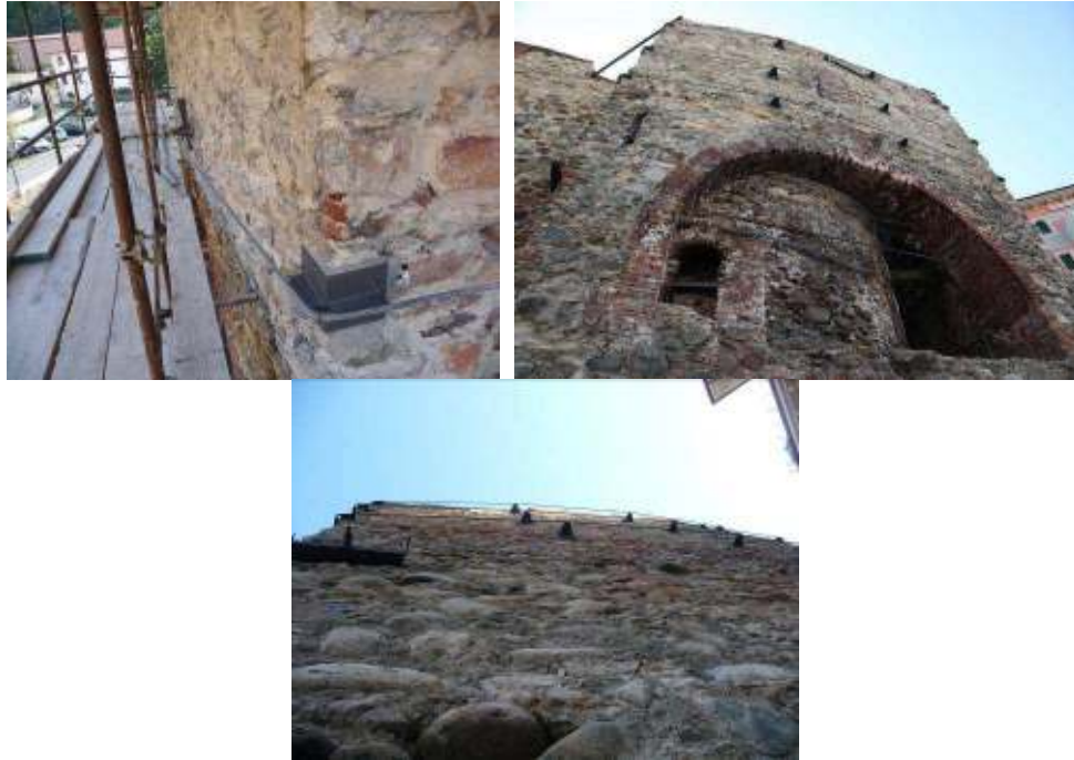
Fig. 5, 6, 7. Tre serie di cerchiature a cavi di acciaio contengono la parte alta della fornace
