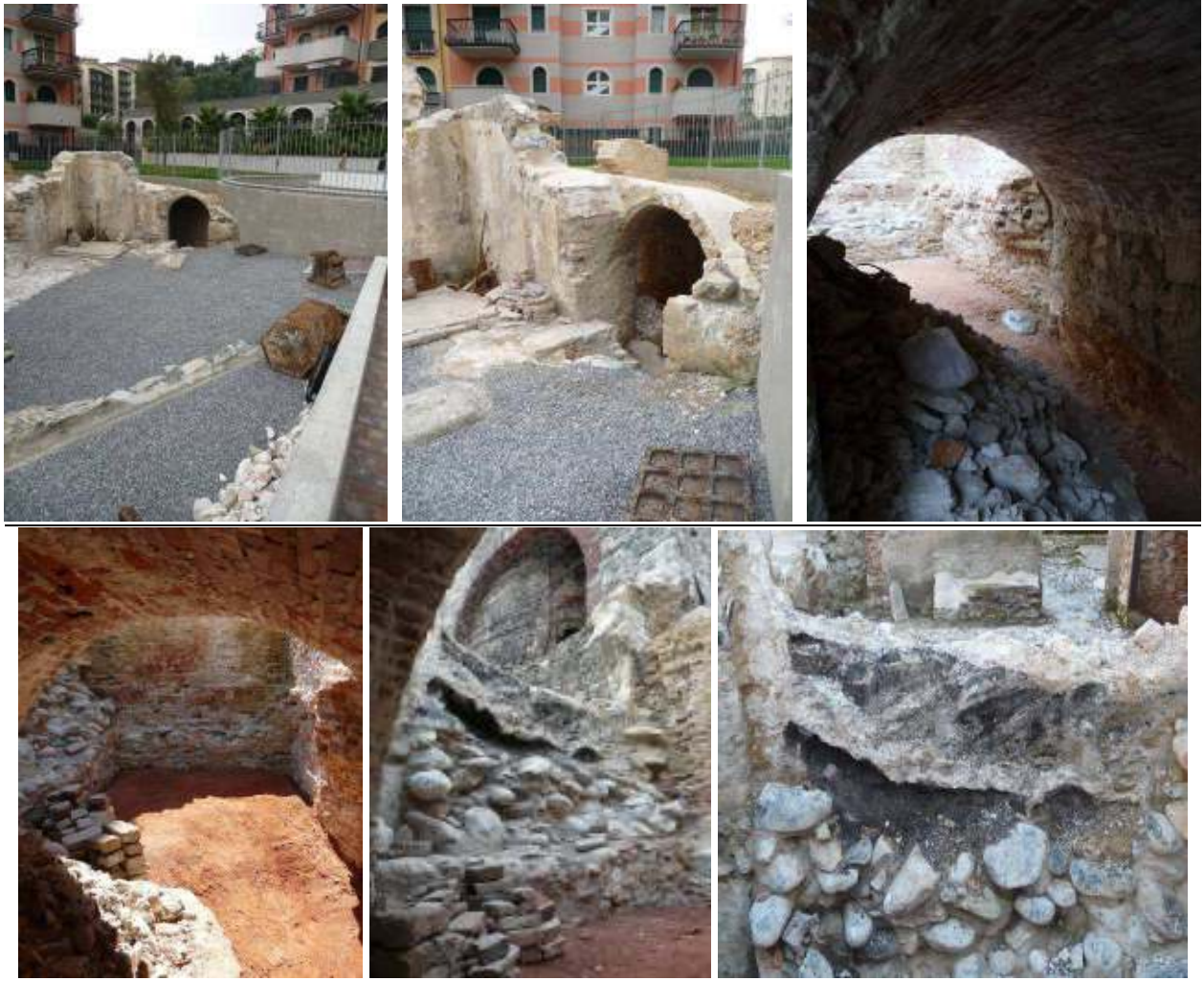
Figg. 22, 23, 24, 25, 26, 27. Attraverso un cunicolo in mattoni (intervento relativo ad una delle ultime fasi del complesso, figg. 22, 23, 24), si arriva al deposito di cocciopesto (fig. 25) e da lì si può ammirare anche un residuo di un deposito storico di calce, rimasto sepolto per quarant'anni (figg. 26, 27). Il deposito storico di calce mostra il sistema di carico a strati alterni dalla pietra da cuocere e del combustibile. In questo deposito sono ancora visibili tutti gli stadi di lavorazione: pietre ancora crude, pietre semi-trasformate e calce.
