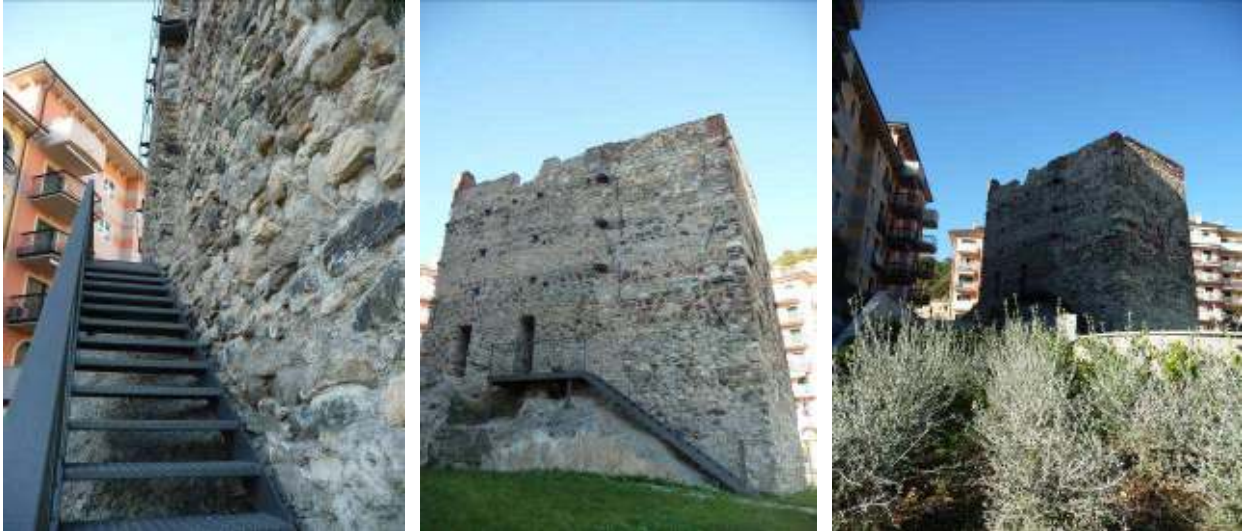
Figg. 28, 29, 30. Fronte sud, la scala di accesso al primo piano della fornace.
