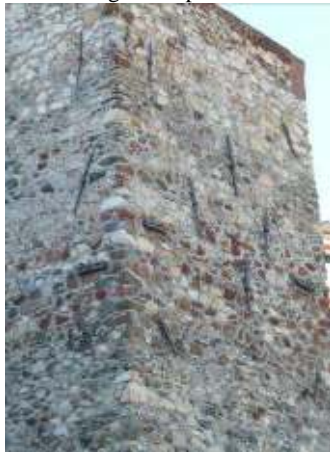
Fig. 8. Nel fronte est sono visibili sia le vecchie catene, sia due nuove catene introdotte nell'intervento di restauro; queste ultime sono ben distinguibili dalle altre per la forma squadrata del bolzone capochiave.
